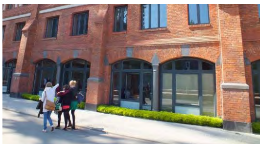
Abbildung 63: Beispiel umgenutzter Industriearchitektur mit Erhalt der historischen Fassade (Berlin)
